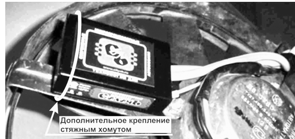
Рисунок 2 – Установка устройства на кронштейне диффузора
