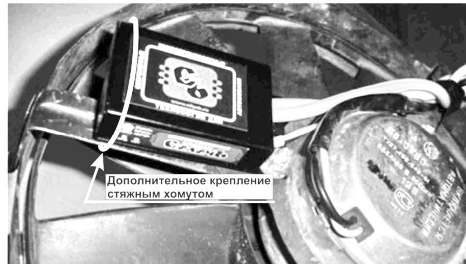
Рисунок 2 – Установка устройства на кронштейне диффузора
